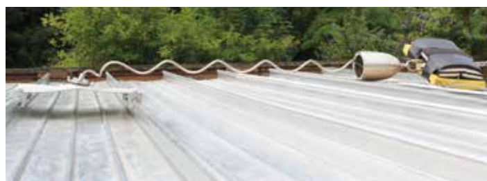
Testing av innfesting i falsetak
