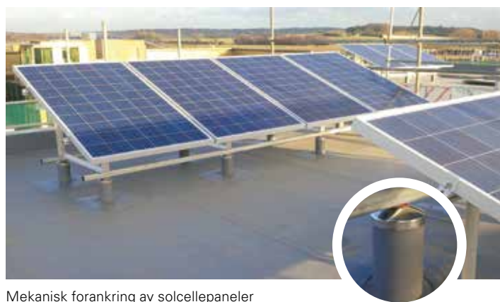
Mekanisk forankring av solcellepaneler
